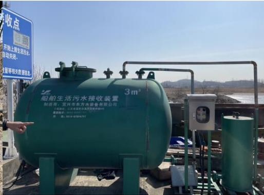
图 9.2-8 码头船舶污水接收装置
